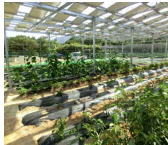
雨樋付き営農型太陽光露地栽培試験場風景
